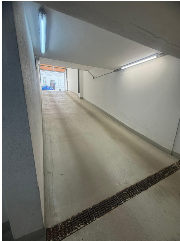
Ein/ Ausfahrt Tiefgarage
