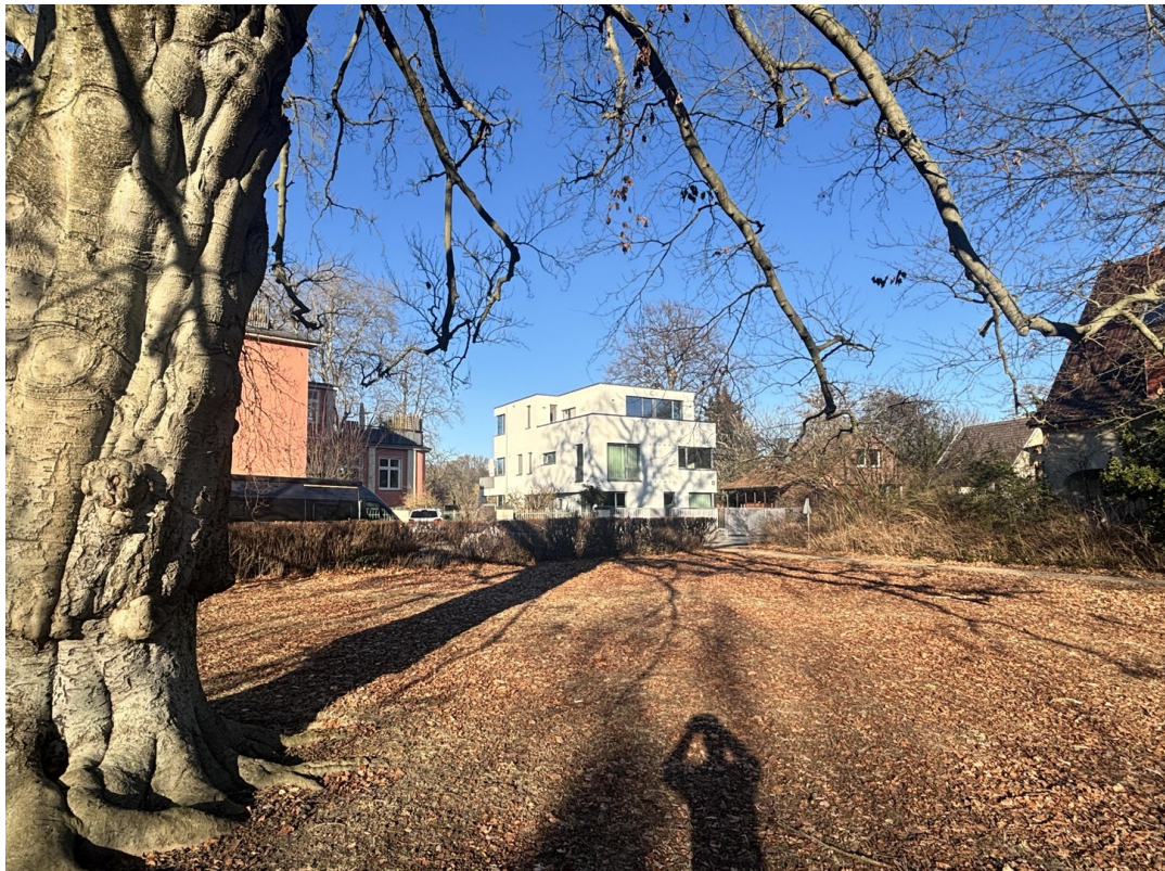
Straßenseite mit Park
