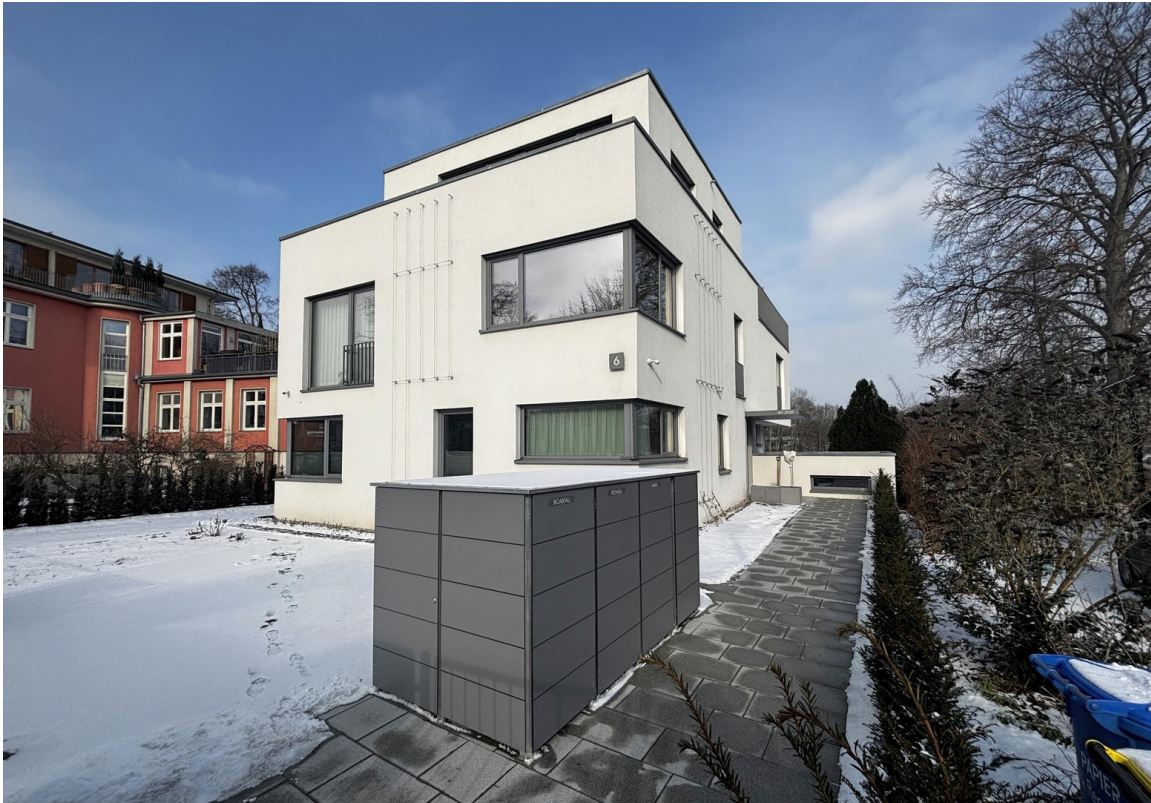
Eingangsweg mit Müllschrank
