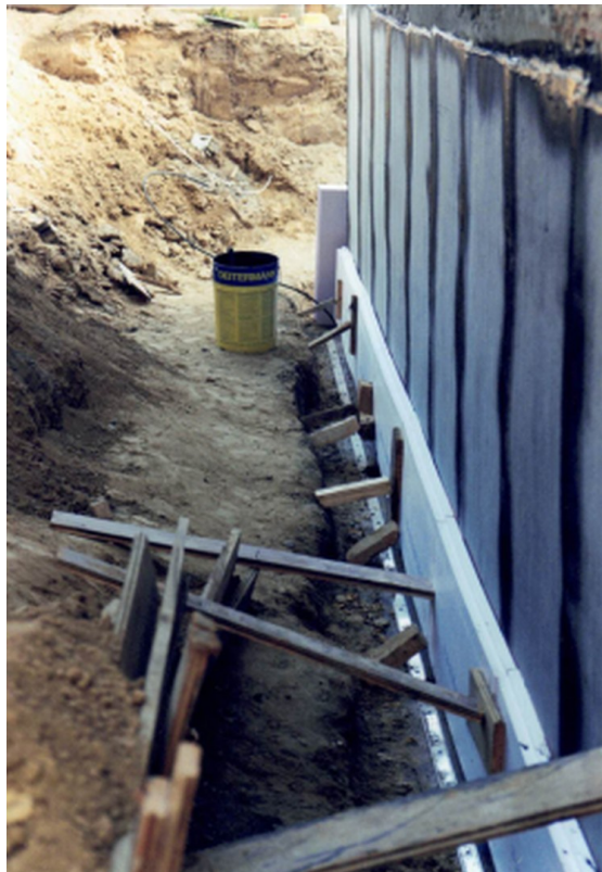
Feuchtigkeit.-Isol. + Dämmung
