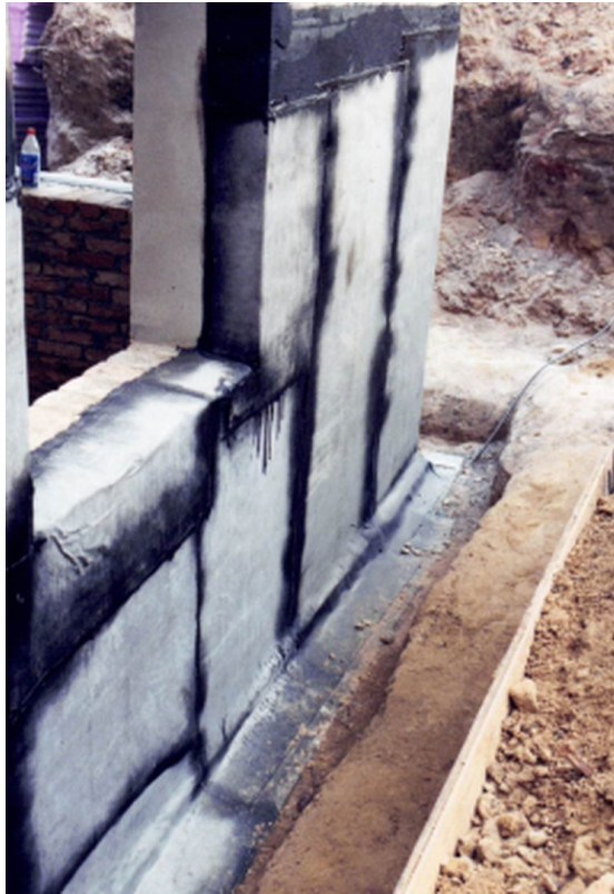
Einbau neue Fundamente
