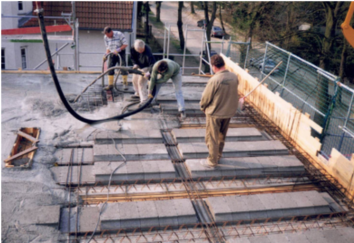
Betonierung der Decken
