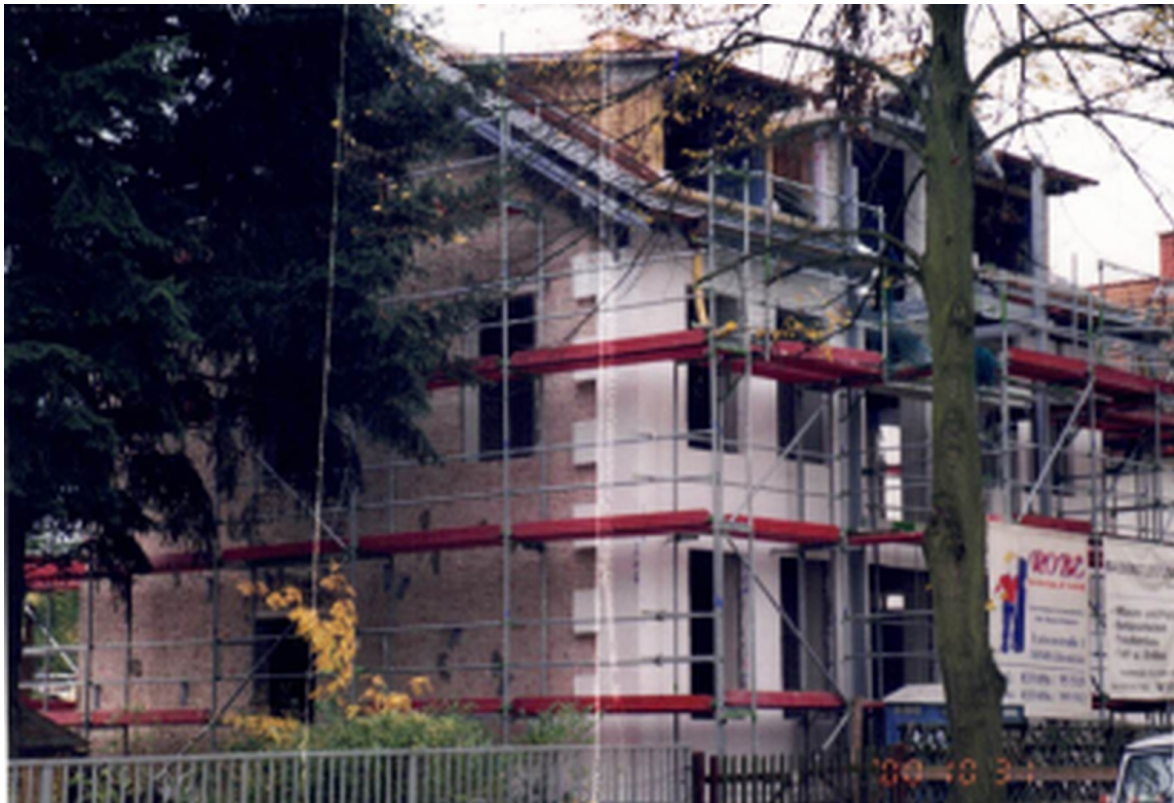
Fassadendämmung
