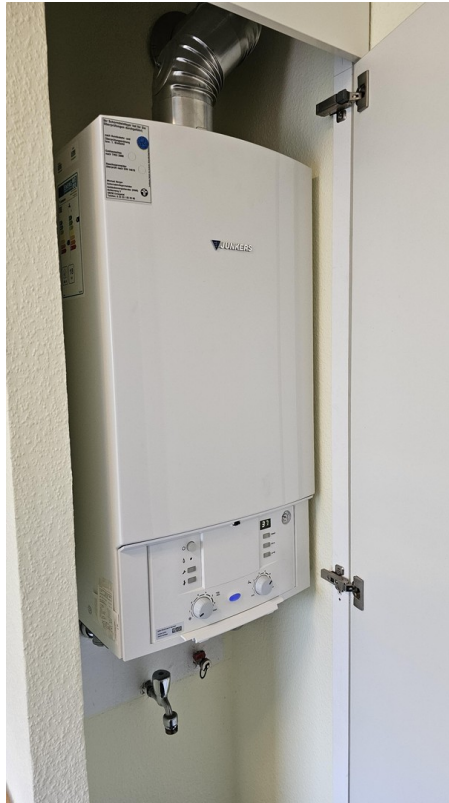
Gasetagenheizung Bosch Junkers
