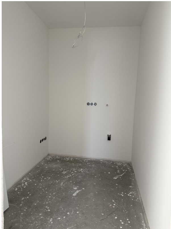
Abstellraum mit WM-Anschluss
