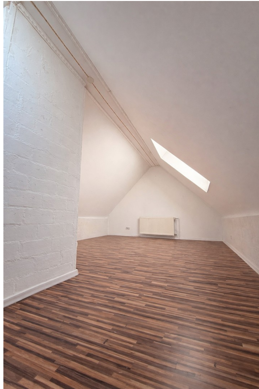
Dachboden (kein Wohnraum)
