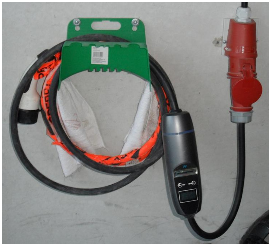
EV Ladekabel 22kW, Garage
