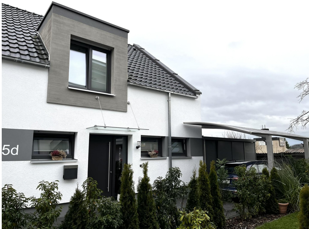
Nordansicht mit Wing-Carport
