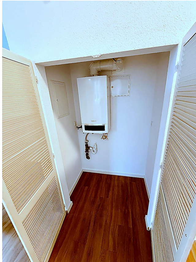
Gasetagenheizung
