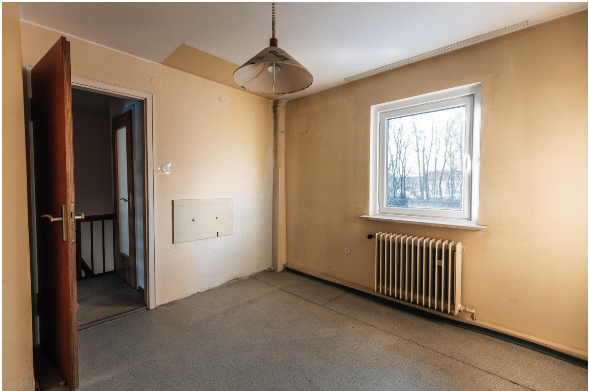
Arbeitszimmer Erweiterung Bad
