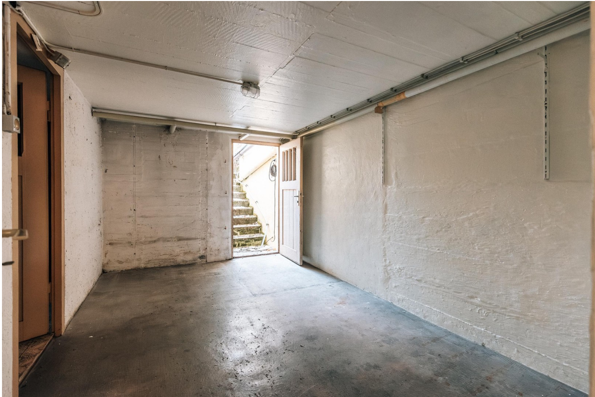
Kellerraum mit Gartenzugang
