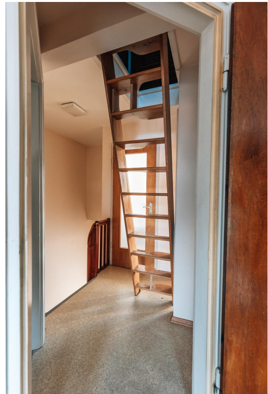
Holzstiege Speicher 1.OG
