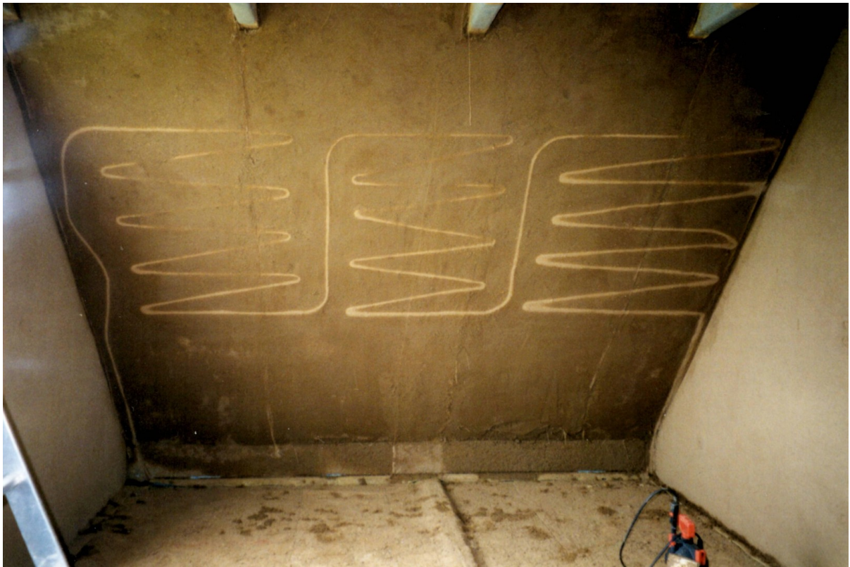
Wandheizung in der Bauphase
