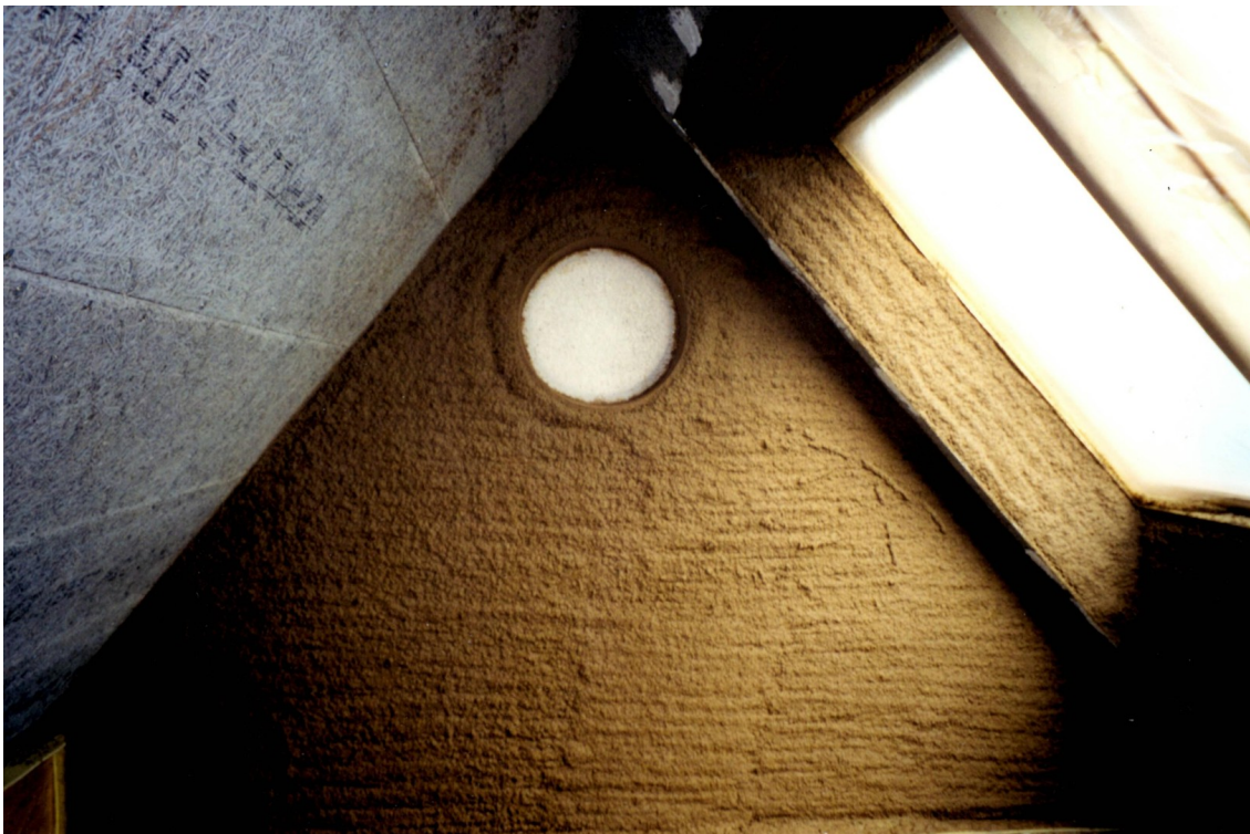
Lehmputz in der Bauphase
