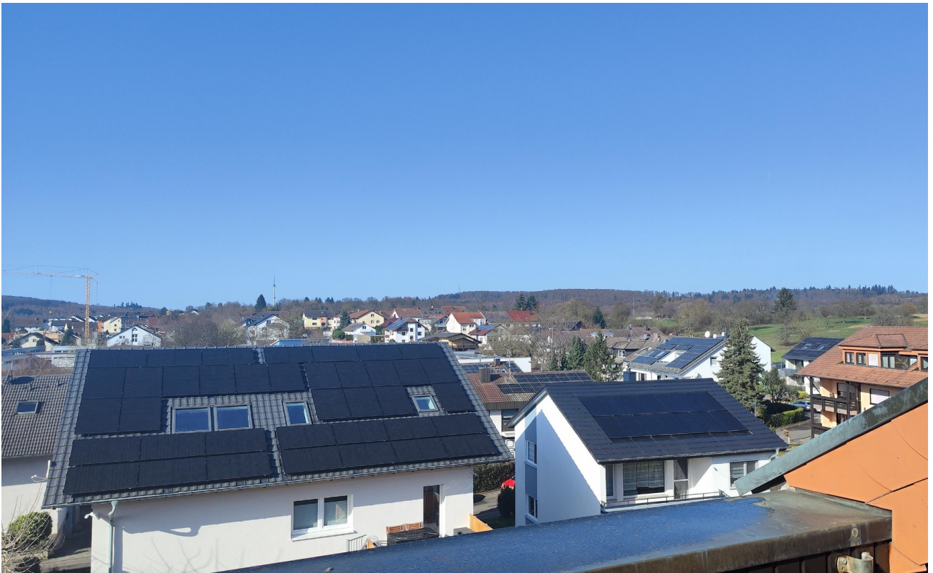
Blick von der Loggia - West
