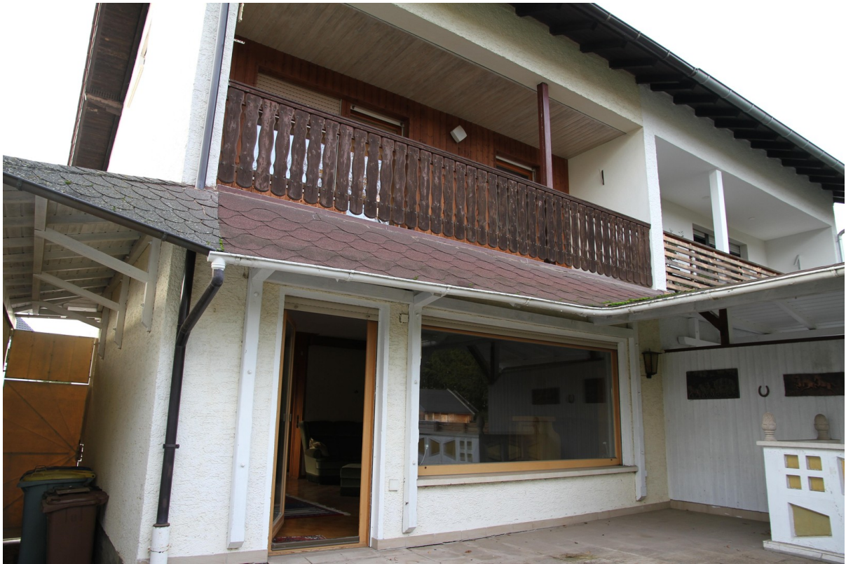
Loggia & große Terrasse
