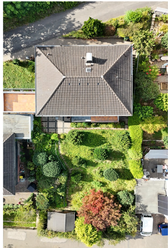
Drohne Haus- und Baugrundstück
