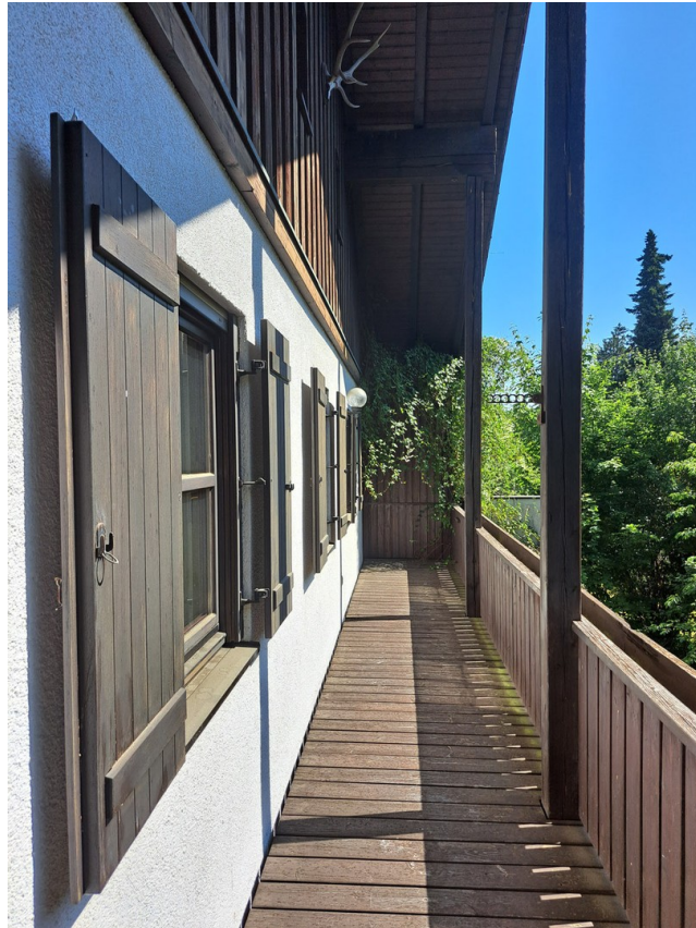
OG Balkon Südosten
