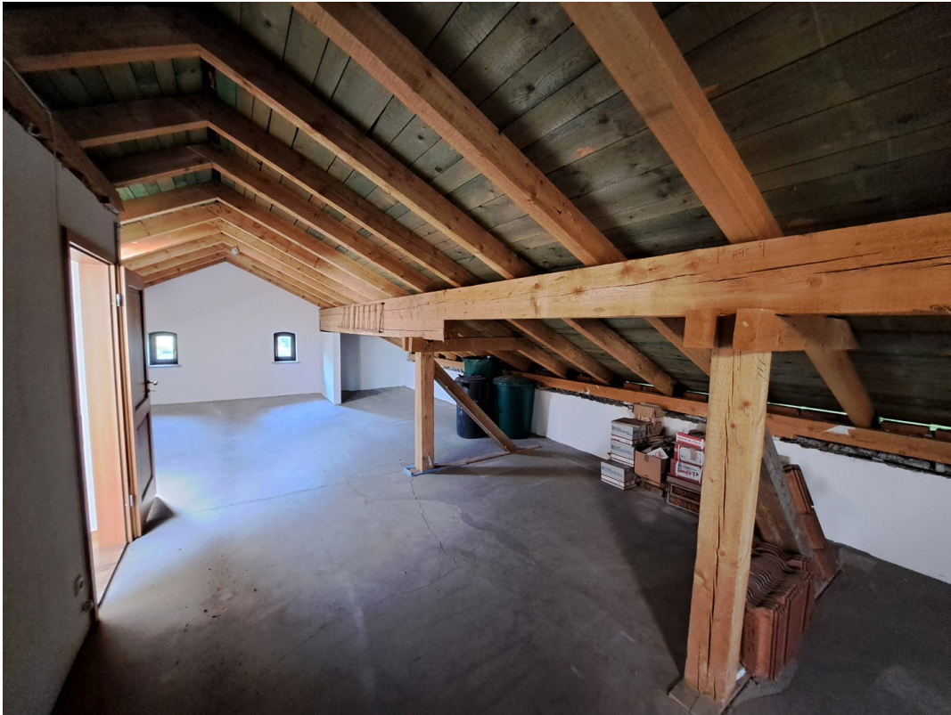
DG Blick durch Dachboden
