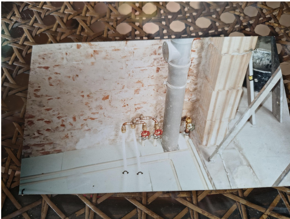
Anschluss Fussbodenheizung
