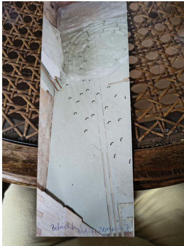
verlegte Fußbodenheizung
