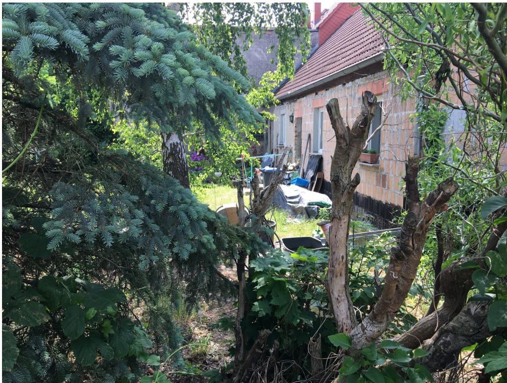
Rückseite vom sanierten Haus
