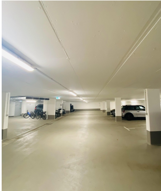
Tiefgarage mit E-Ladestation
