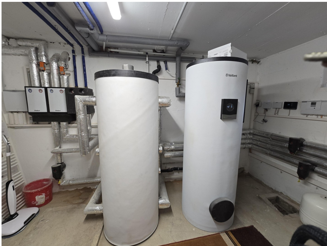
Wärmepumpenanlage
