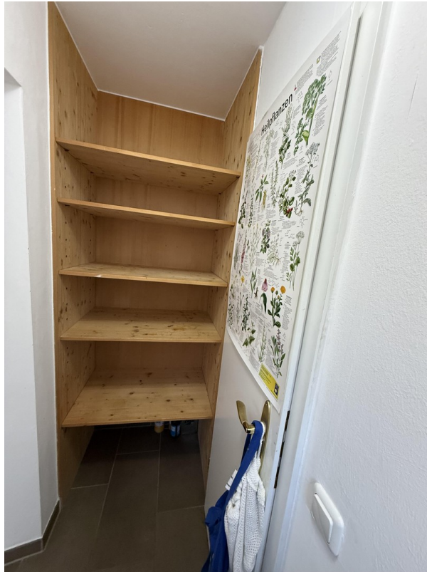
Vorratsraum mit Einbauregal
