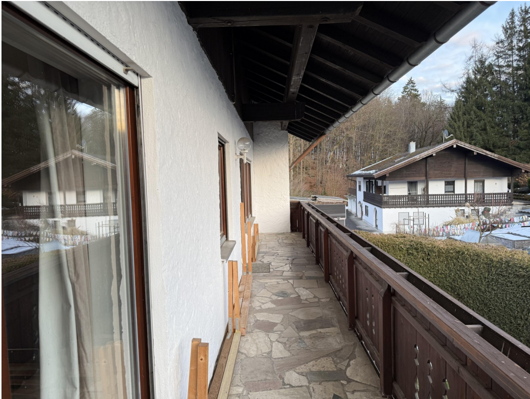
Balkon - Blickrichtung Osten
