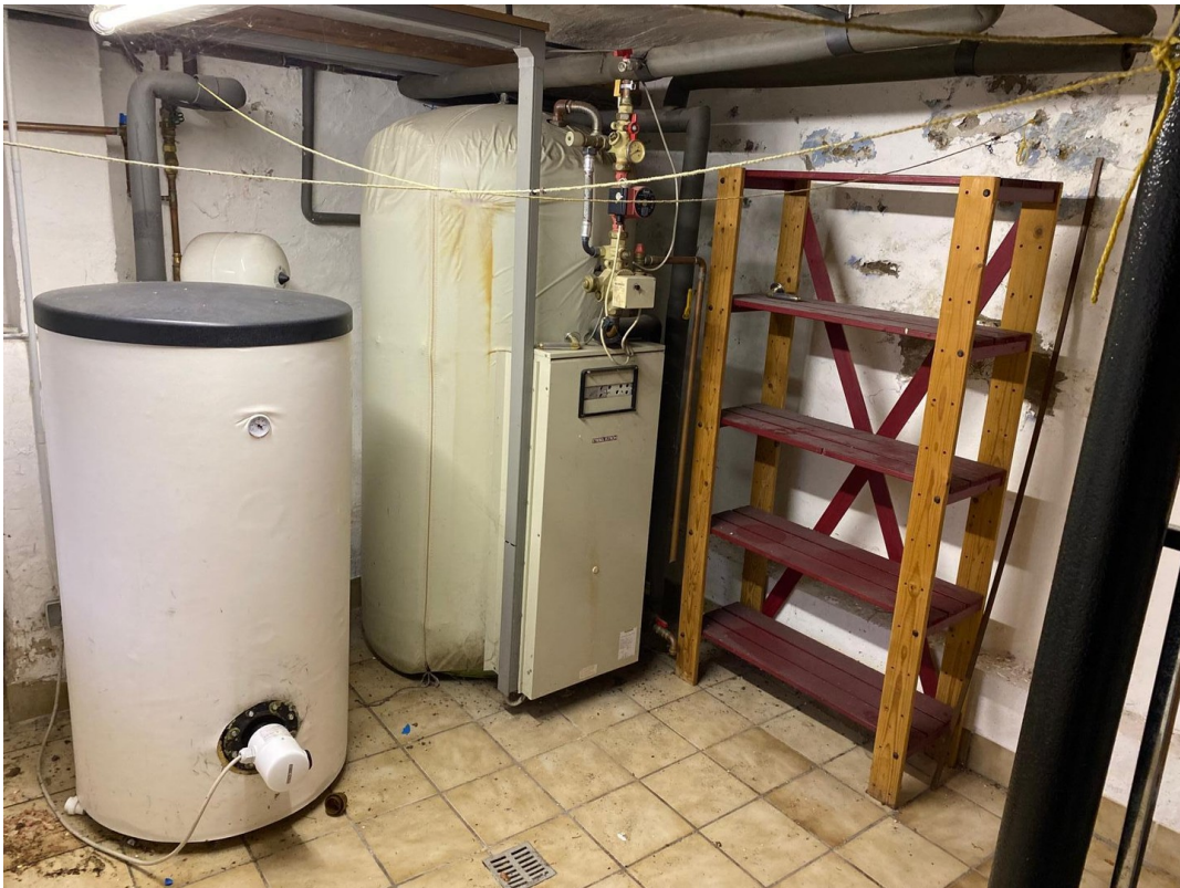
Warmwasserspeicher Keller
