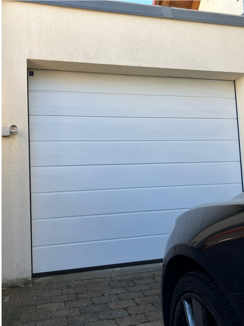
Garage und Parkplätze
