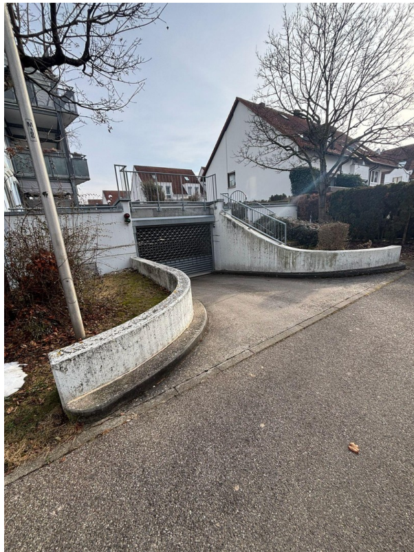
Zufahrt zur Tiefgarage
