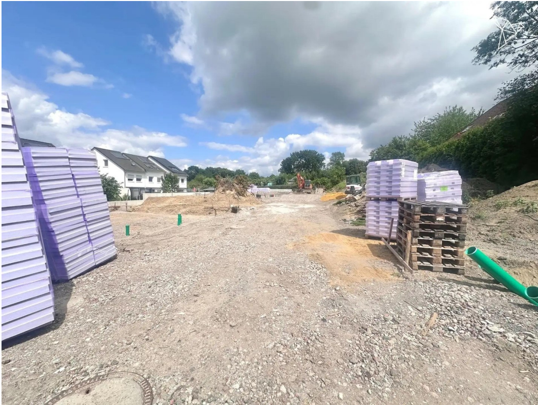
Fotos von der Baustelle
