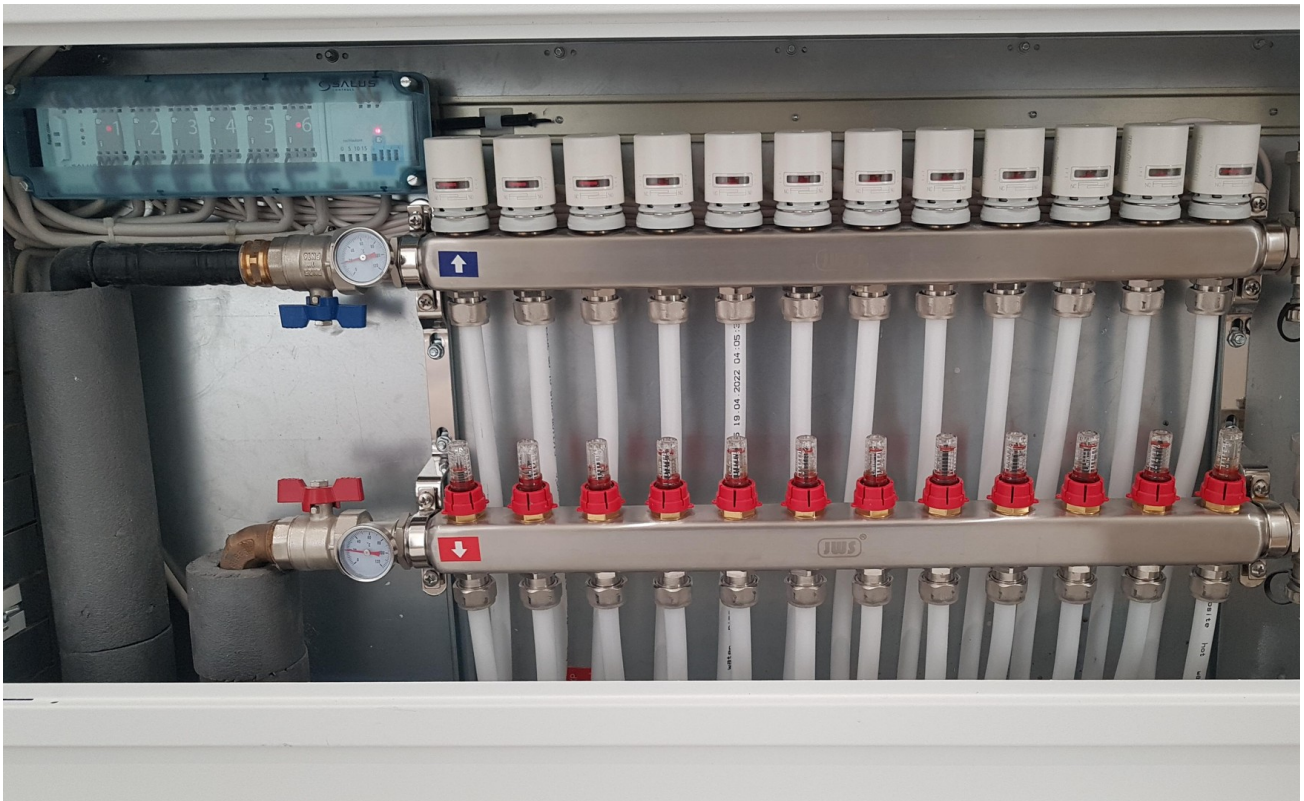
FB Heizkreisverteiler
