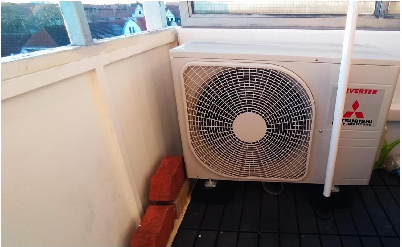
Wärmepumpe (Klimo)
