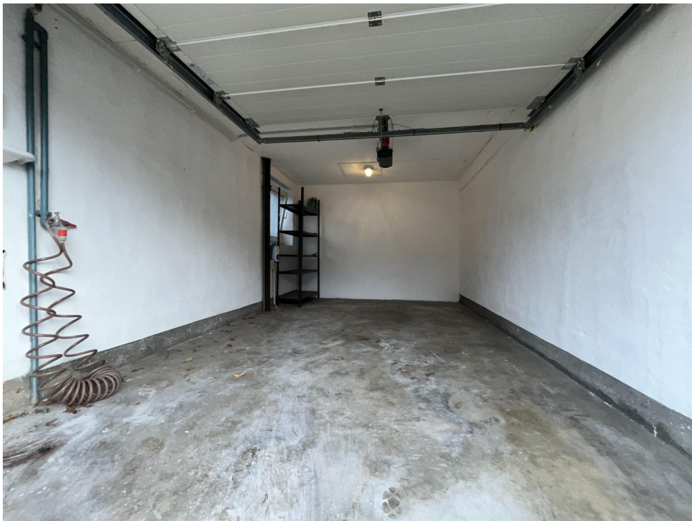
Garage mit Wasseranschluss
