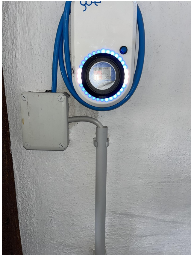
Anschluss für Wallbox 11 kW
