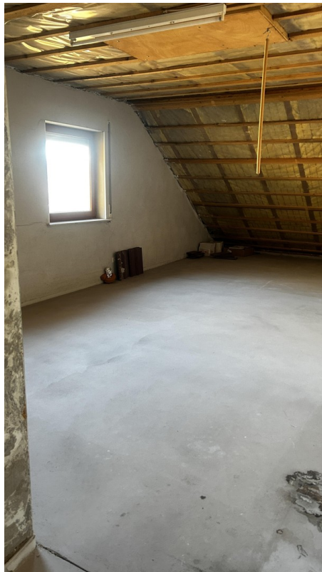
Zum Ausbau vorbereitet
