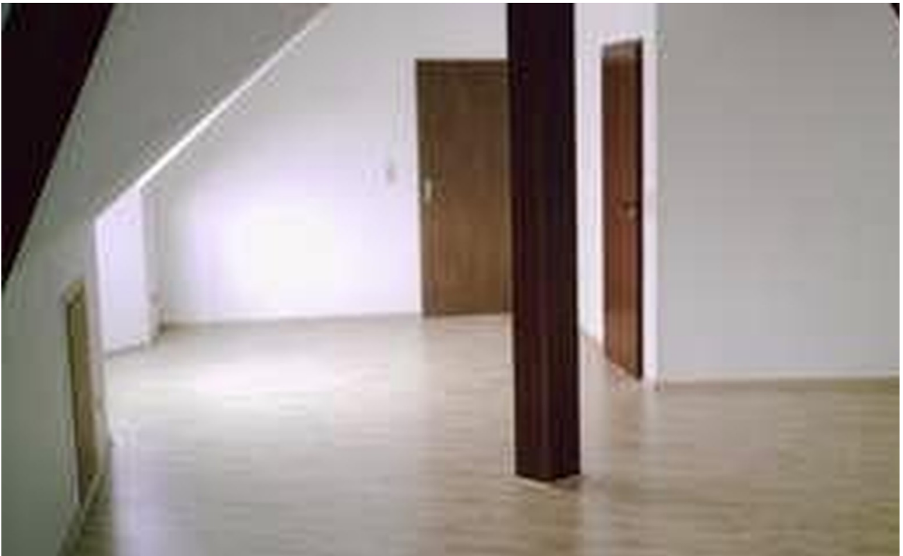
Schöne Holzbalken im Dach
