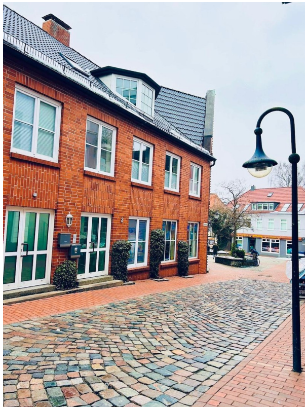
grosse helle Fensterflächen
