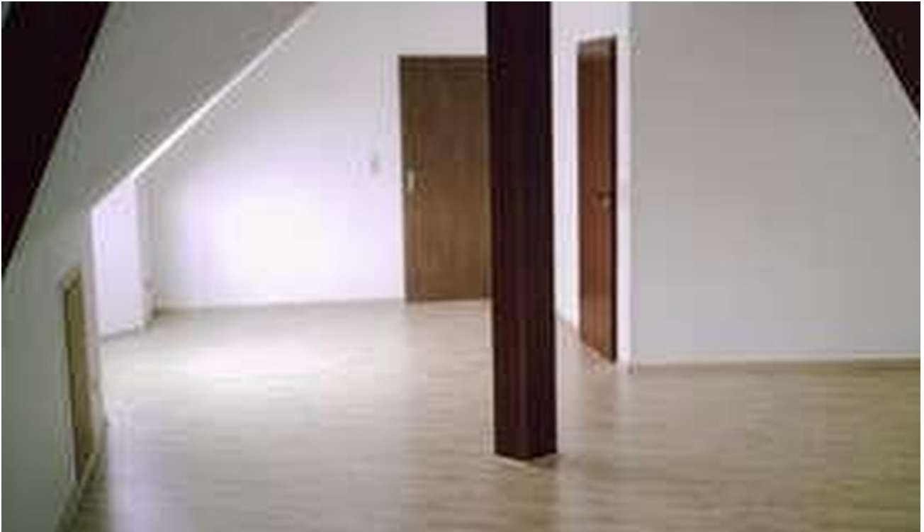
Schöne Holzbalken im Dach
