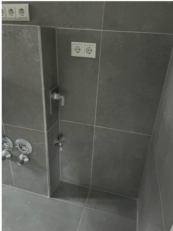
Waschmaschinenanschluss
