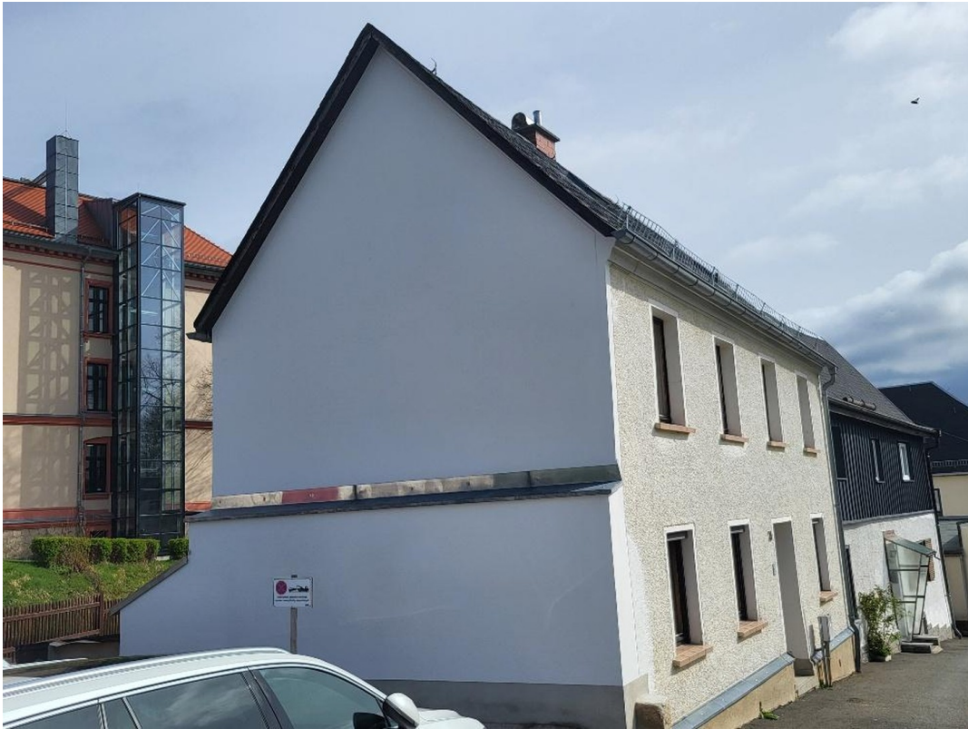
Giebelseite neu geputzt
