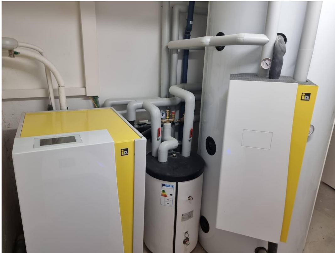
Technikraum Wärmepumpe
