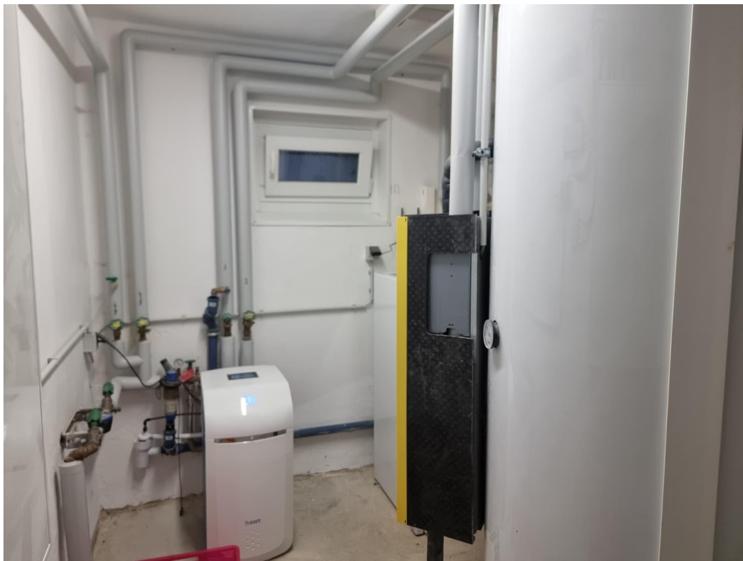
Technikraum Trinkwasserentkalk
