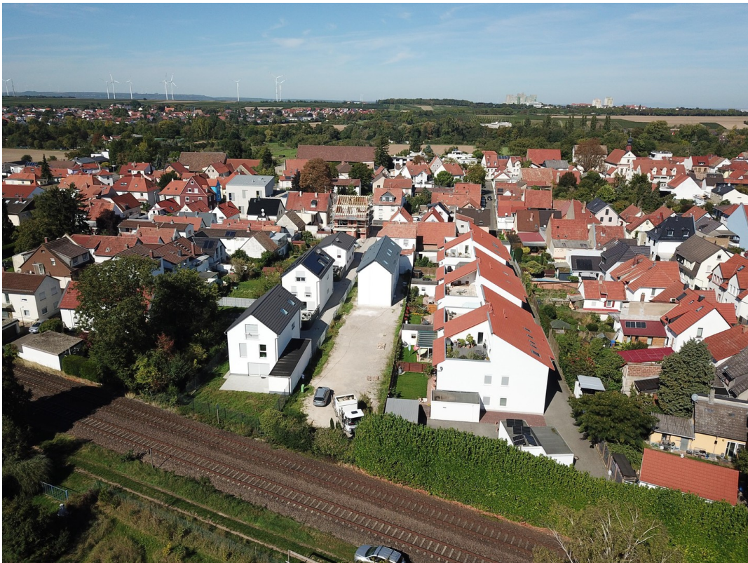
Blick auf Bauplatz
