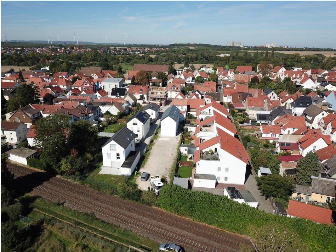
Blick auf Bauplatz
