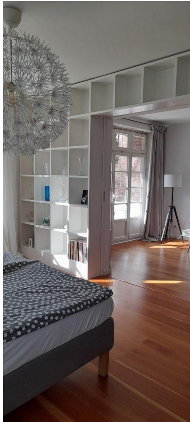
Durchbruch (mit Schiebetür)
