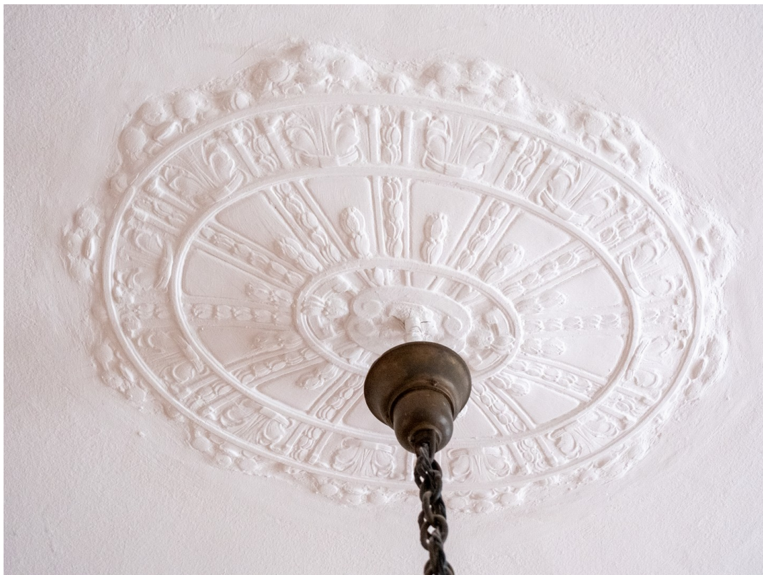
Stuckrosette im Balkonzimmer
