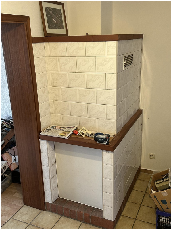
EG Ofen außer Betrieb
