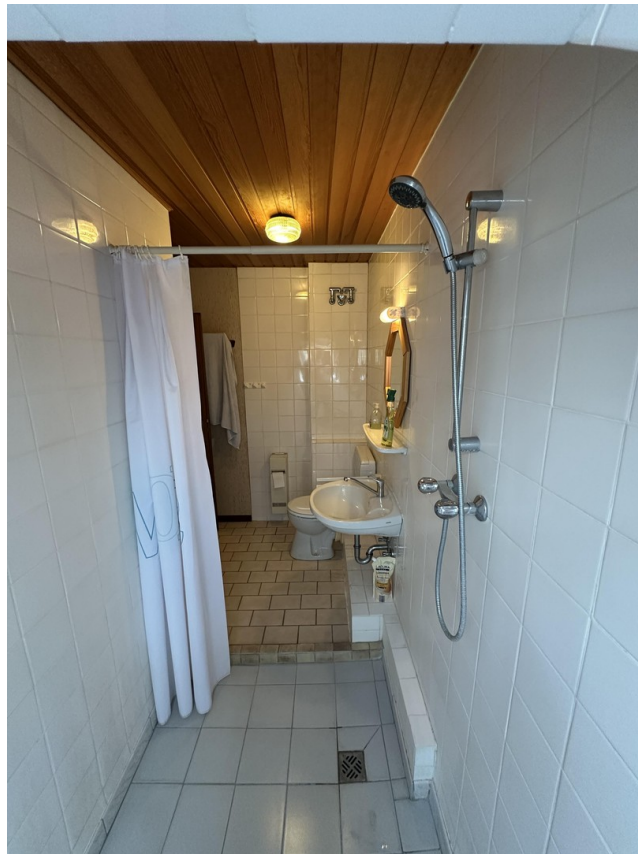
DG WC mit großer Dusche 3
