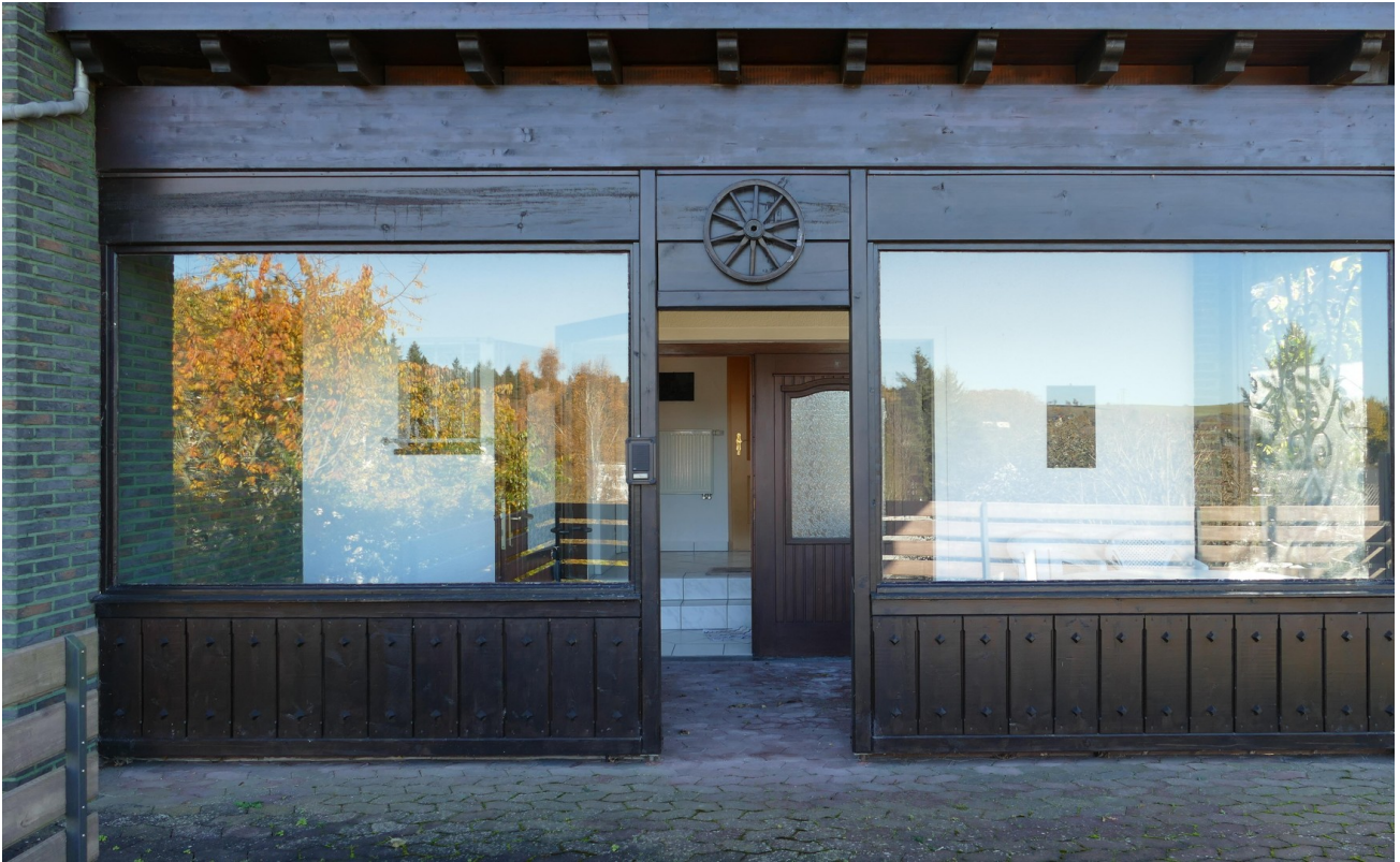
UG: Eingang mit Terrasse
