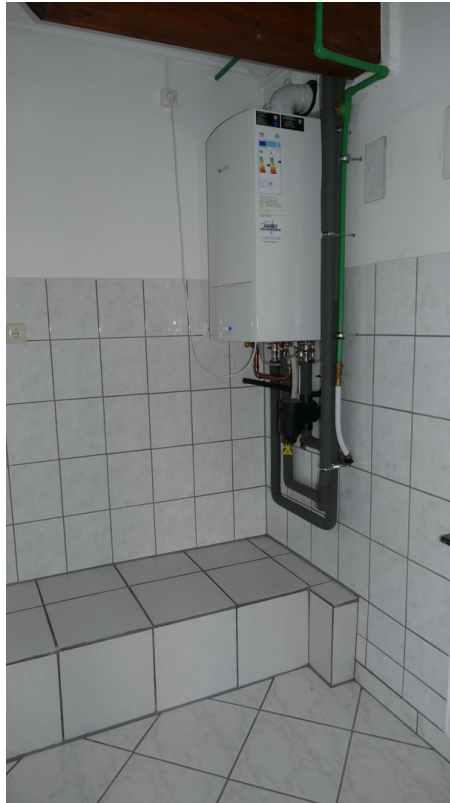
UG: Heizung und Waschraum
