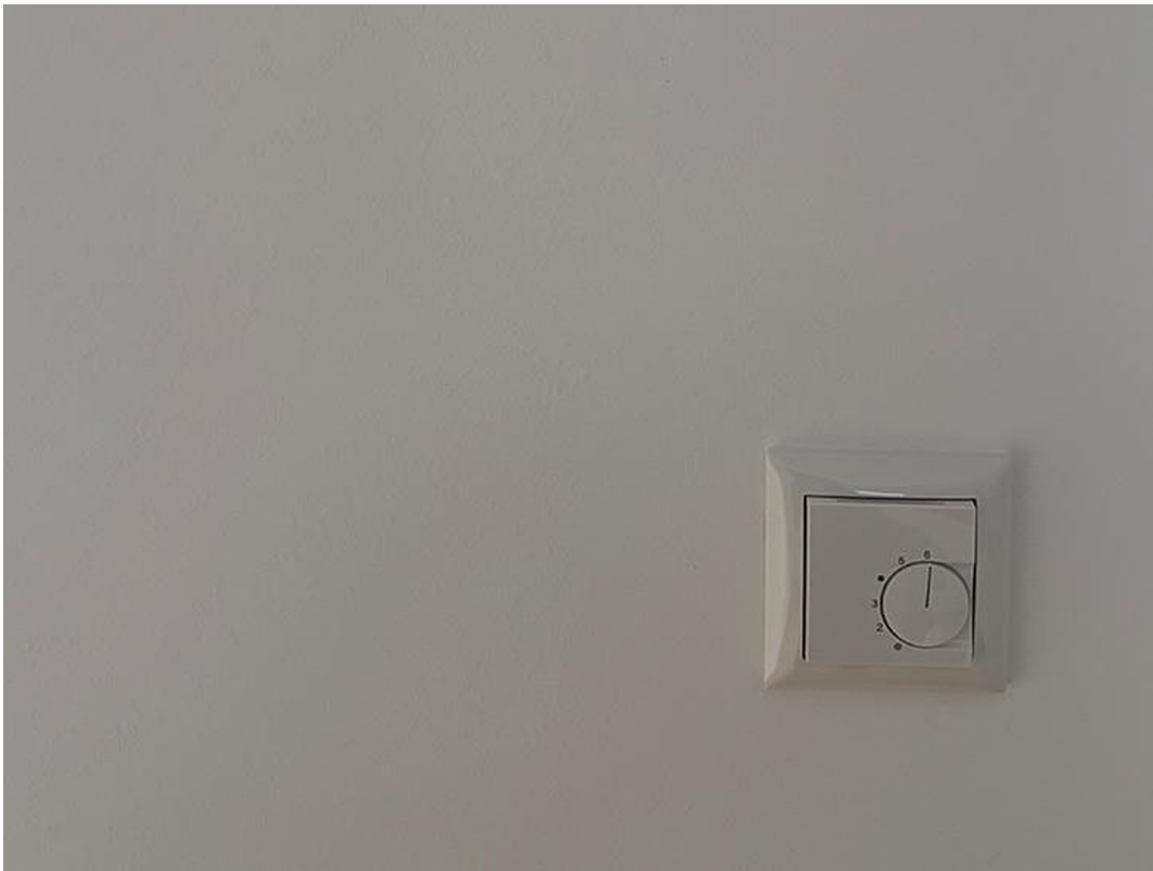
Fußbodenheizung raumgesteuert
