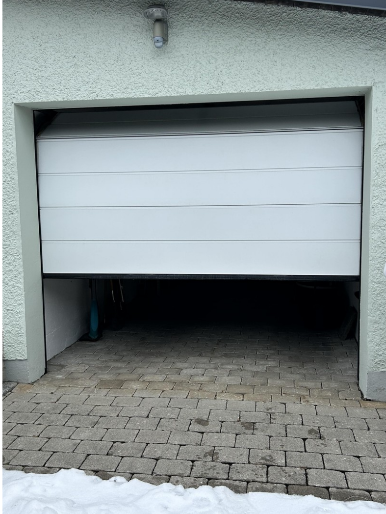
Garage mit elektr. Torantrieb
