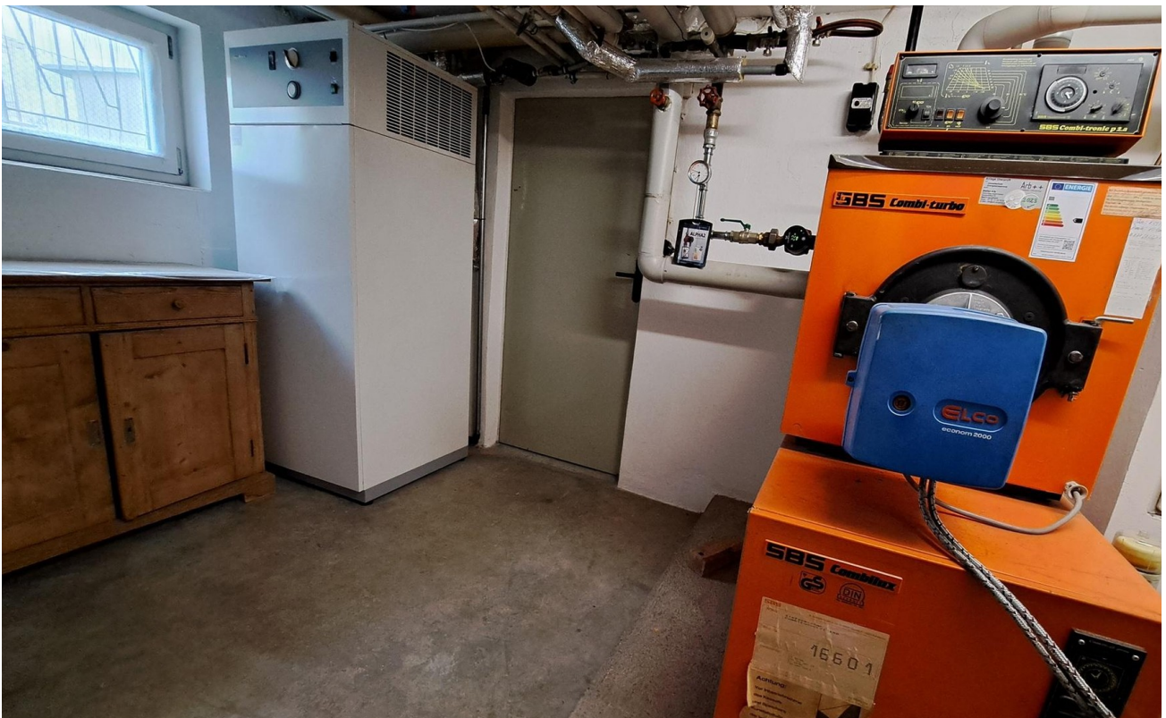
Heizraum-Wärmepumpe/Ölbrenner
