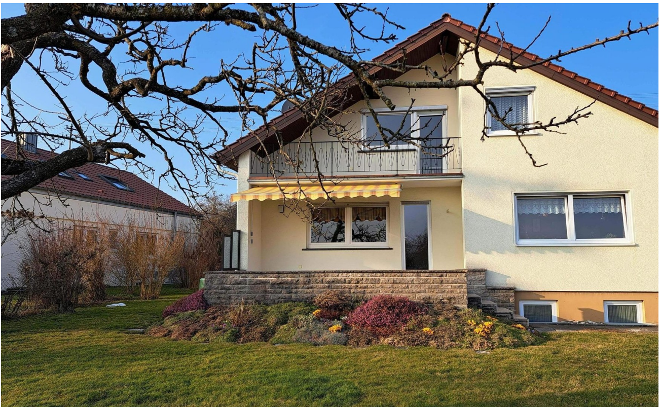
Südseite mit Sonnenterrasse
