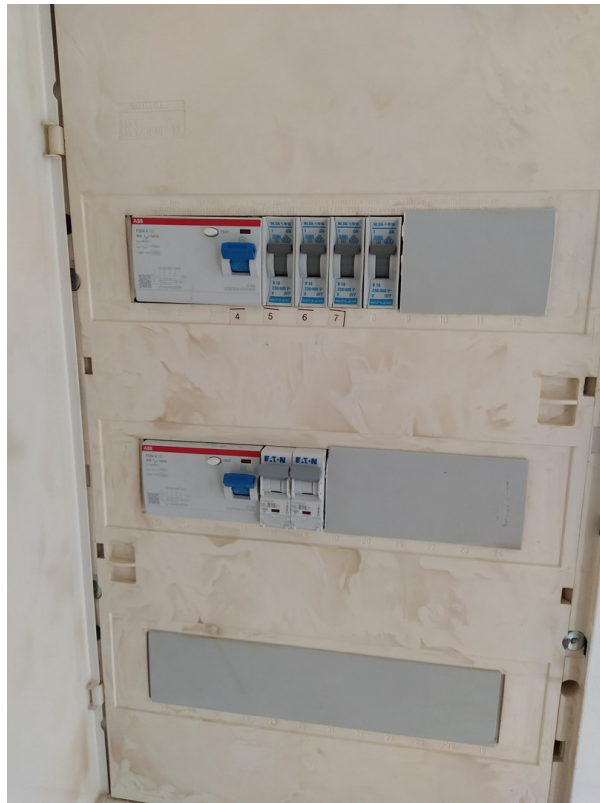
Sicherungskasten mit FI
