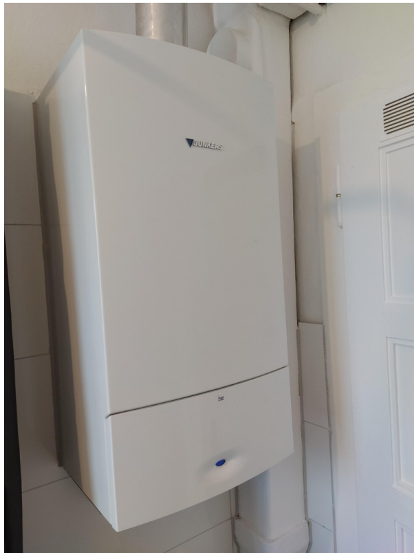
Gasetagenheizung
