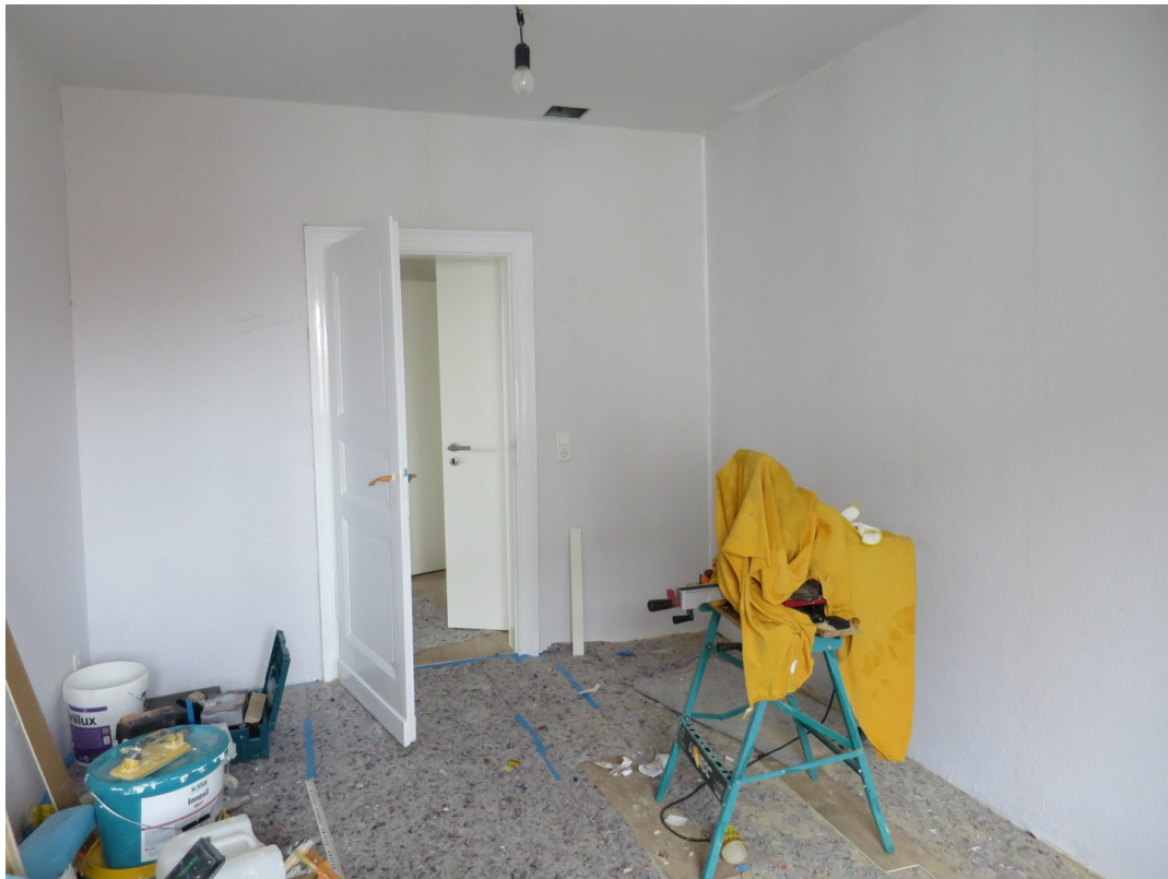
Raum 5 (Foto aus Umbauphase)
