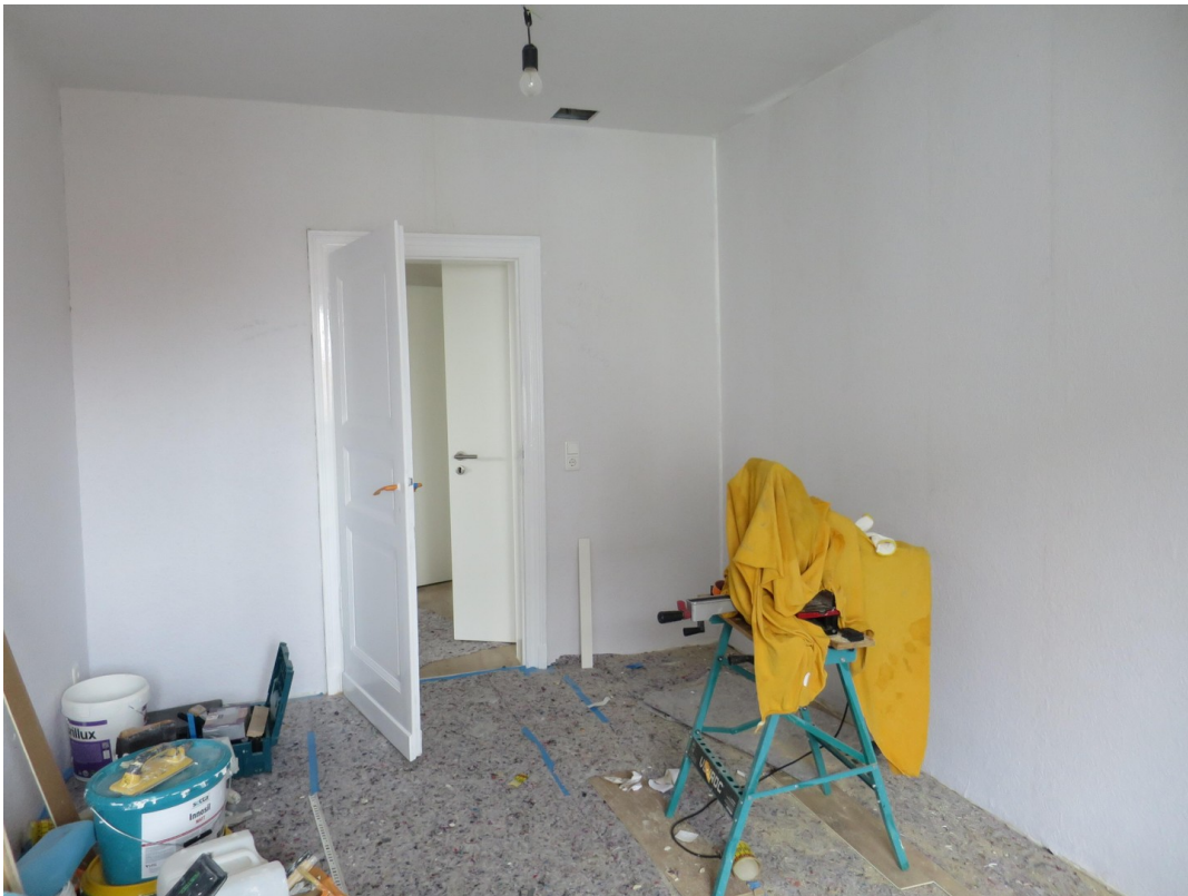
Raum 5 (Foto aus Umbauphase)
