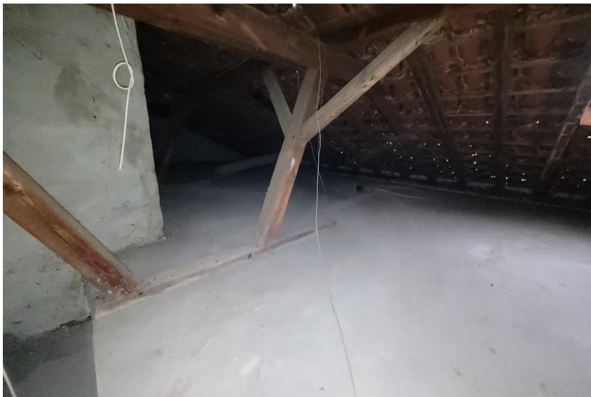
Foto B 15: DS-Lagerraum (1)
