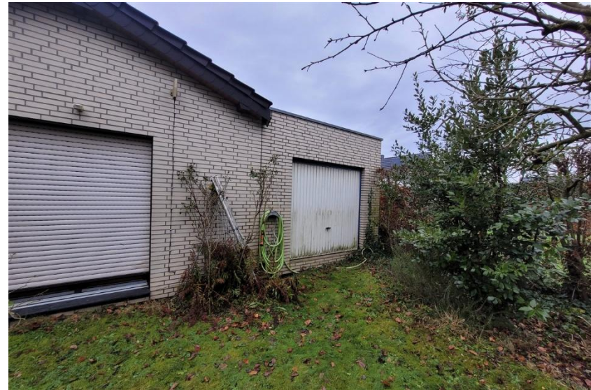
Foto A 10: Abstellraum - links - Rückansicht
