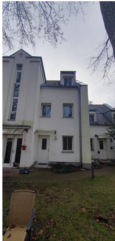
externer Eingang zur Wohnung
