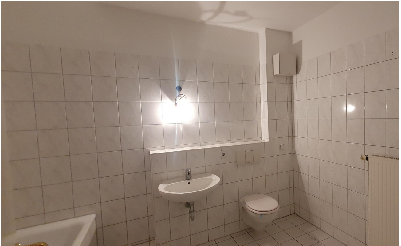
Bad OG Waschbecken WC
