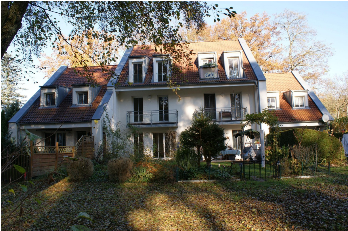
Gesamtanlage mit 6 Einheiten
