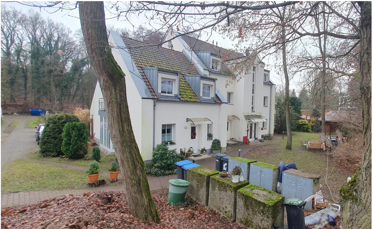
Gesamtanlage von vorne
