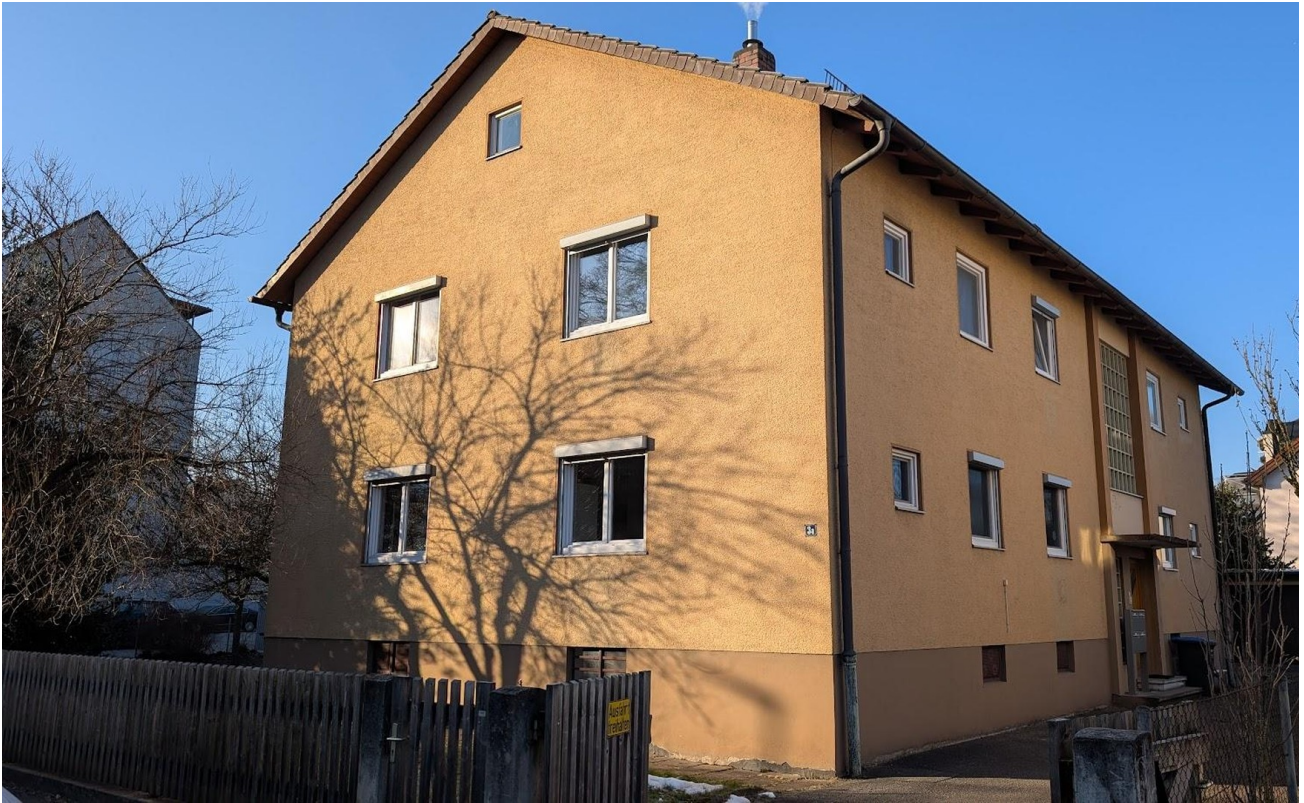
Hausfront von der Straße
