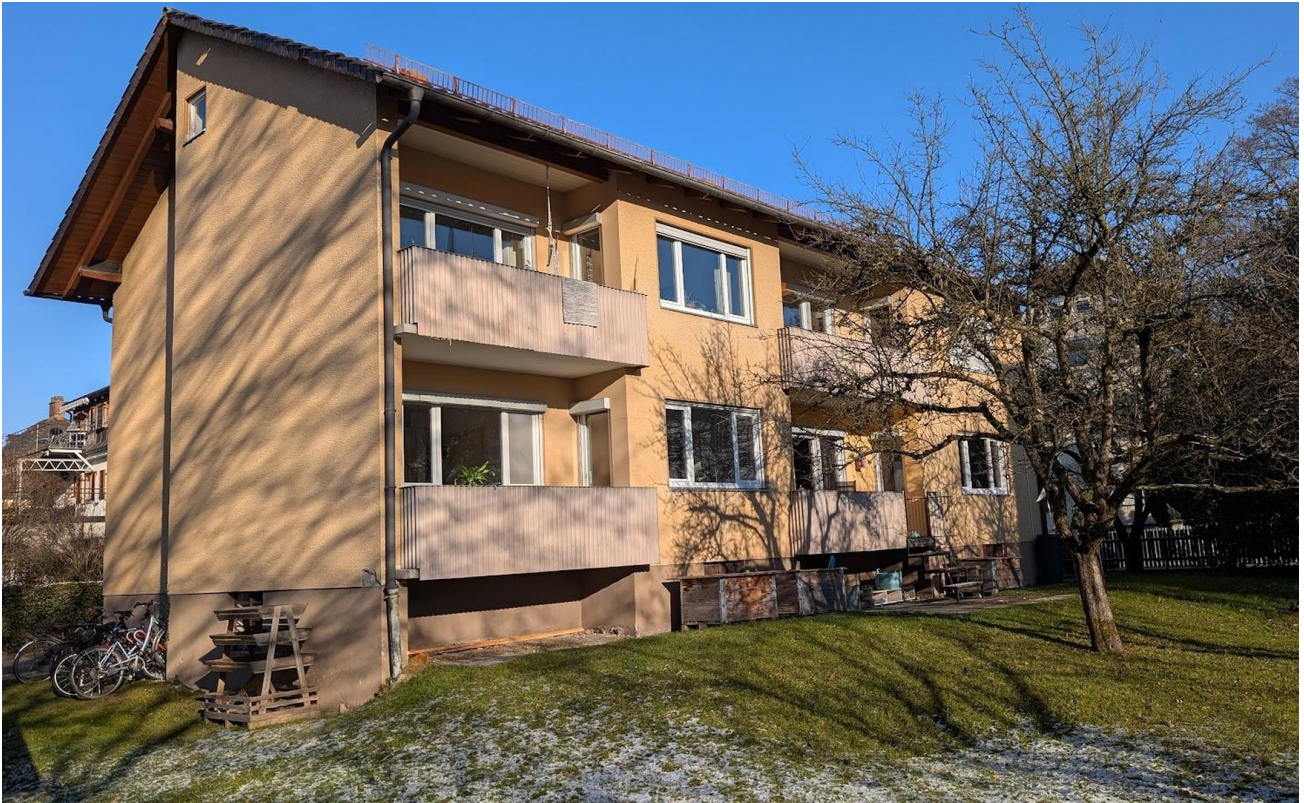
Hausansicht aus Südwest
