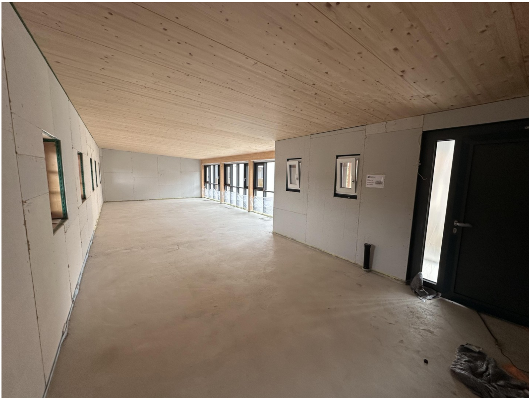
Blick in den Raum
