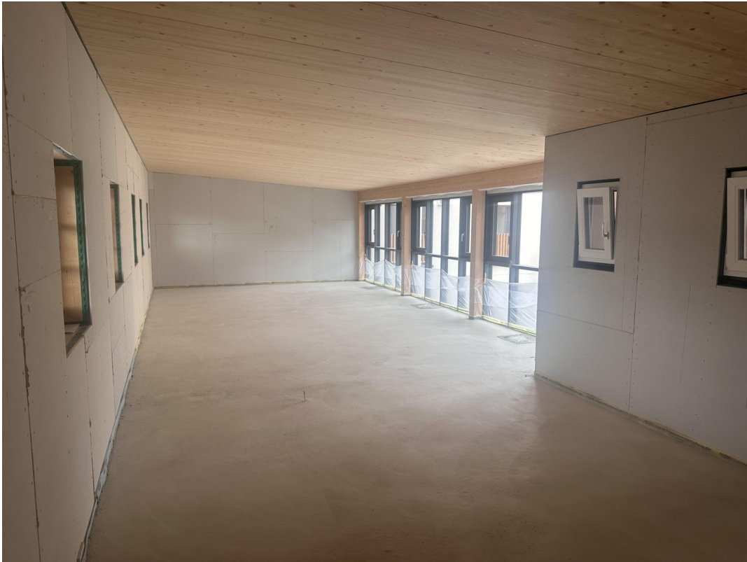
Blick in den Raum
