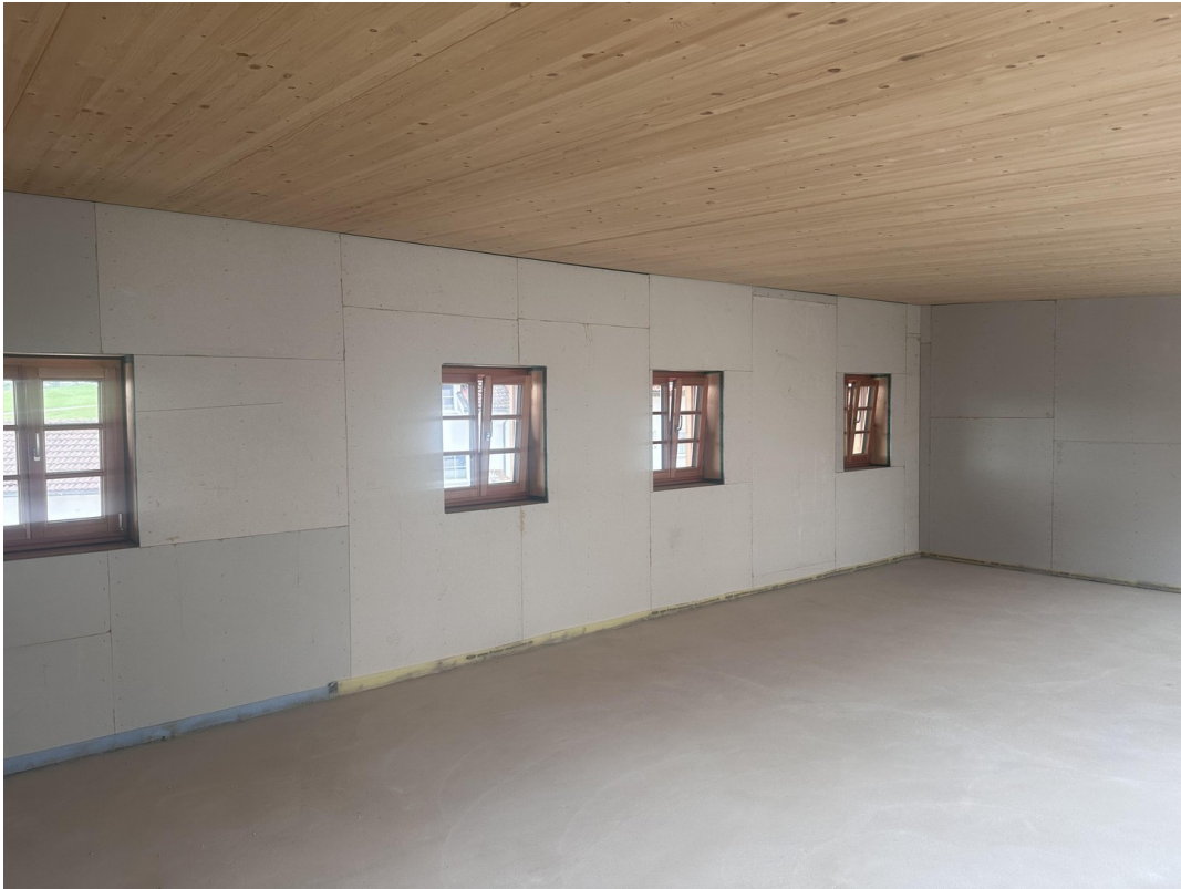
Fenster zur Straße
