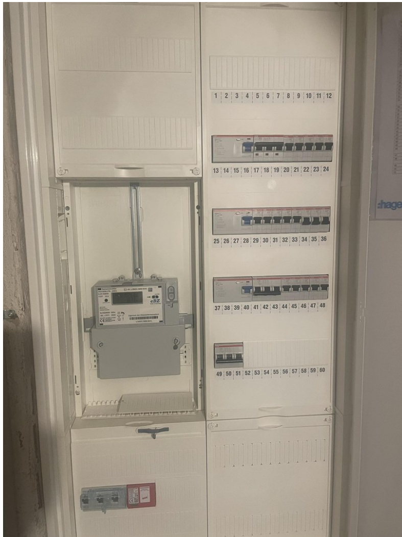
Stromverteilerkasten
