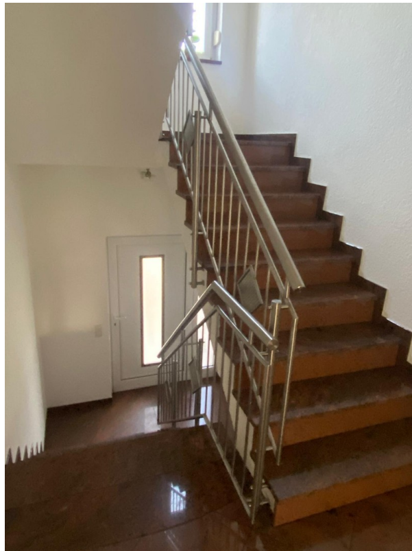
Flur EG, Treppenhaus
