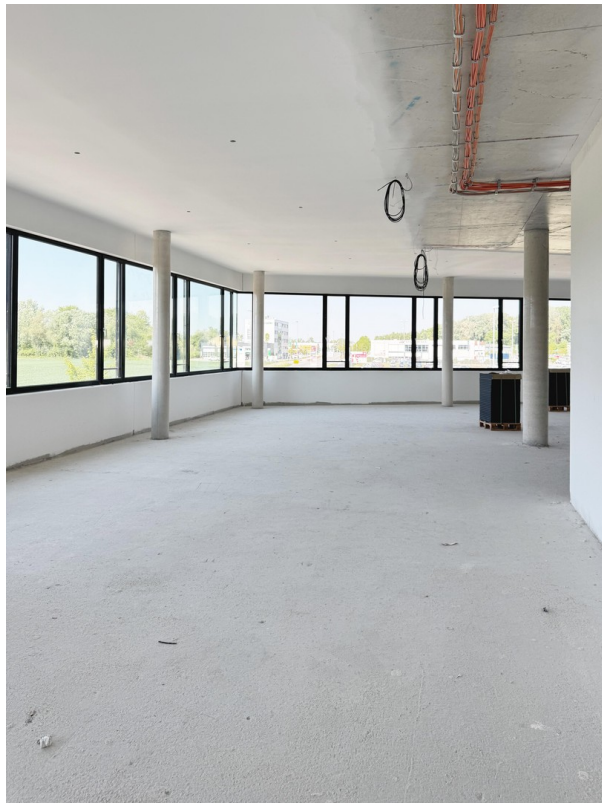
O1/O2 - Rohbau f. Mieterausbau
