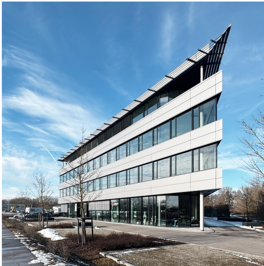
Gebäude - Manchinger Str.
