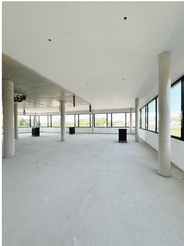
O1/O2 - Rohbau f. Mieterausbau
