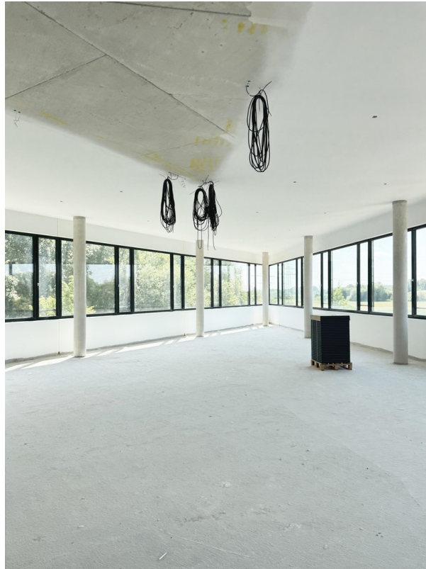
O1/O2 - Rohbau f. Mieterausbau
