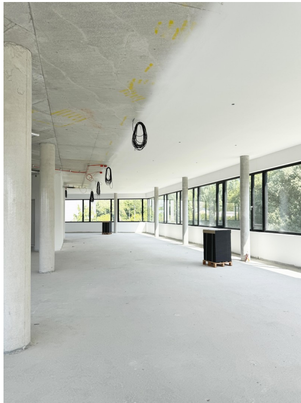
O1/O2 - Rohbau f. Mieterausbau
