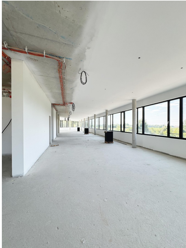
O1/O2 - Rohbau f. Mieterausbau
