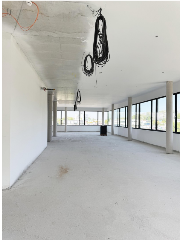
O1/O2 - Rohbau f. Mieterausbau
