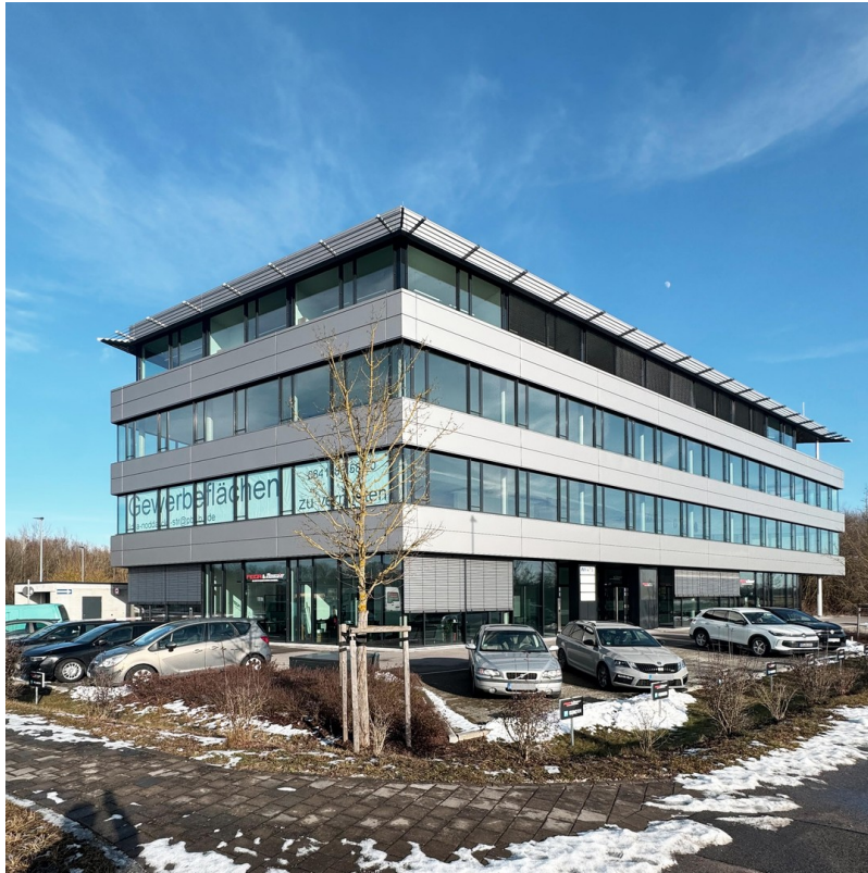
Gebäude - Manchinger Str.
