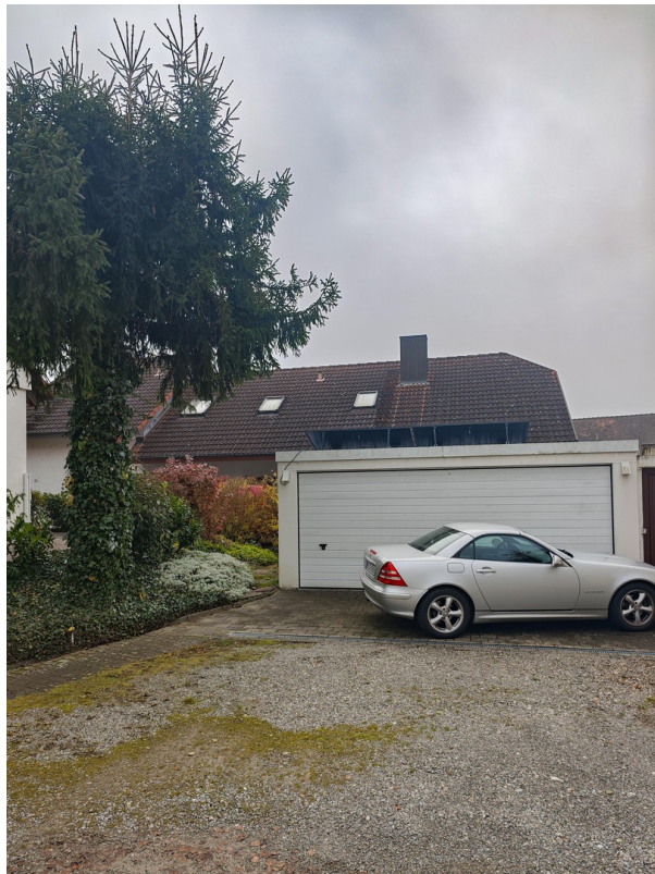
Doppelgarage mit Stellplatz
