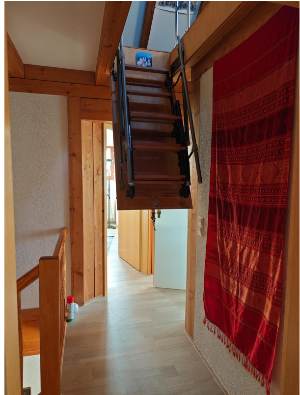
Zugangleiter zum Dachboden
